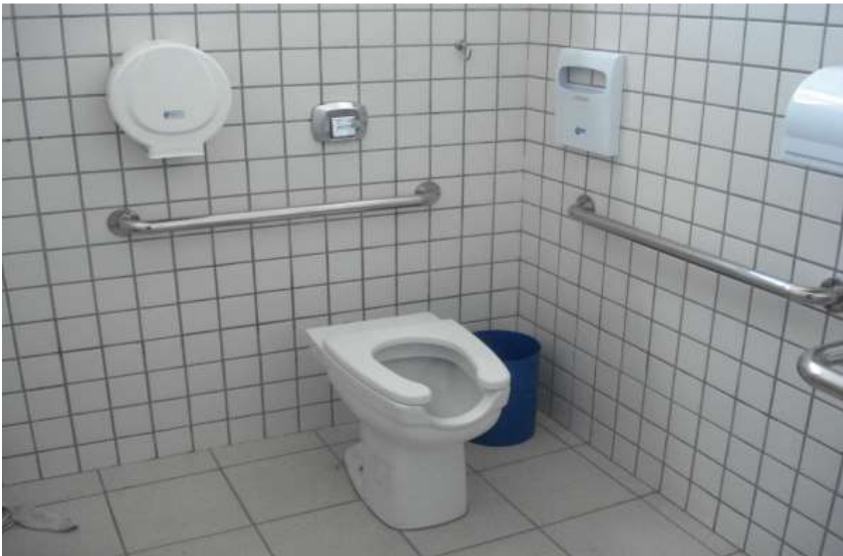
Banheiro adaptado para usuários portadores de necessidades especiais
