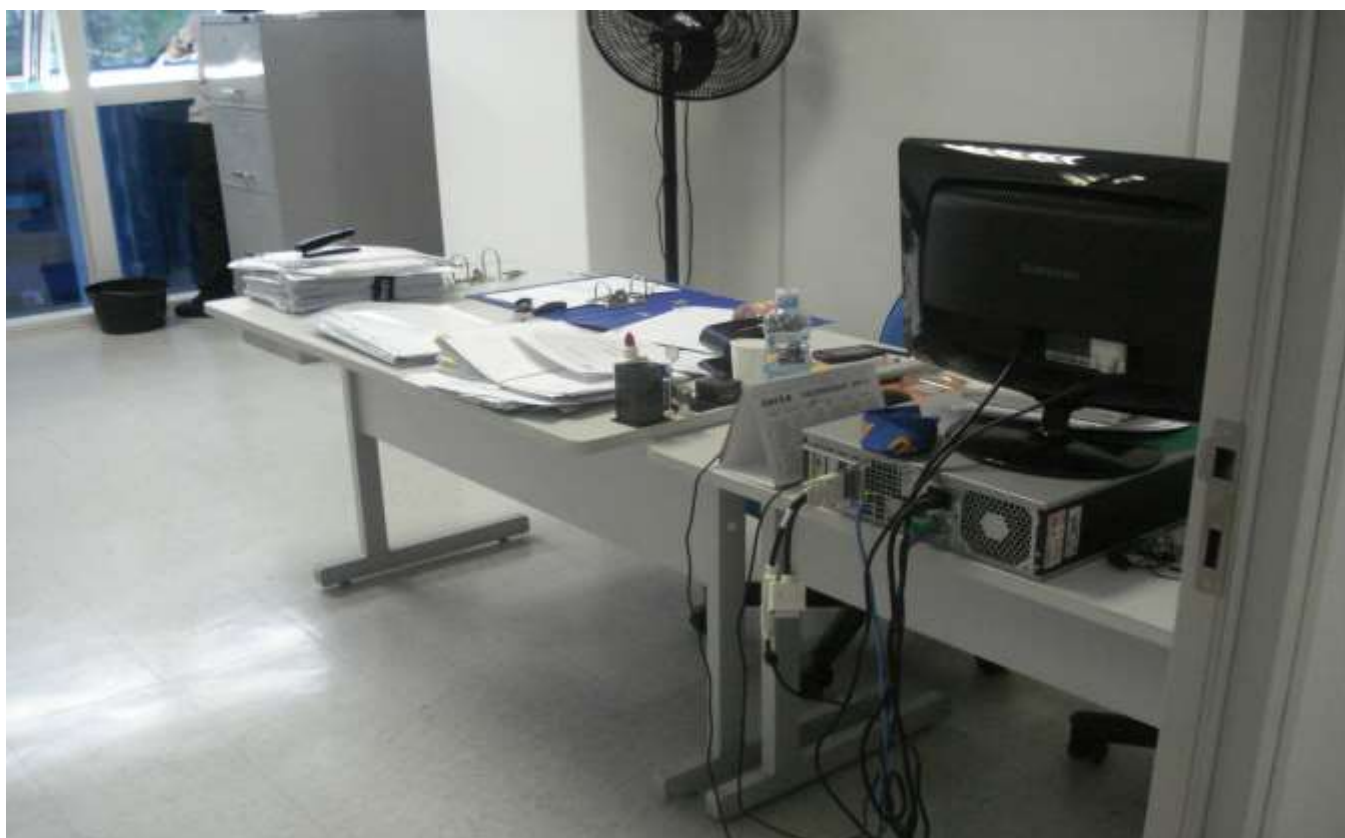
Sala de servidor administrativo
