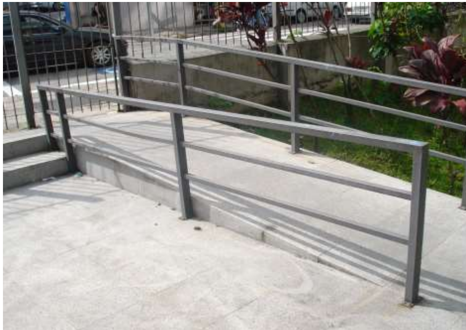
Rampa de acesso na entrada
