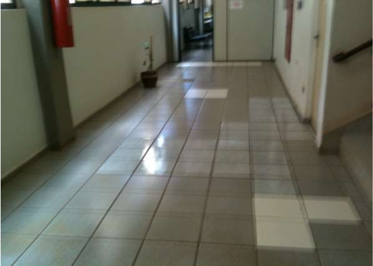
PROBLEMAS DE PISO DESCOLANDO – EFEITO DE PROBLEMA ESTRUTURAL QUE VEM SENDO TRATADO PELO INSS
