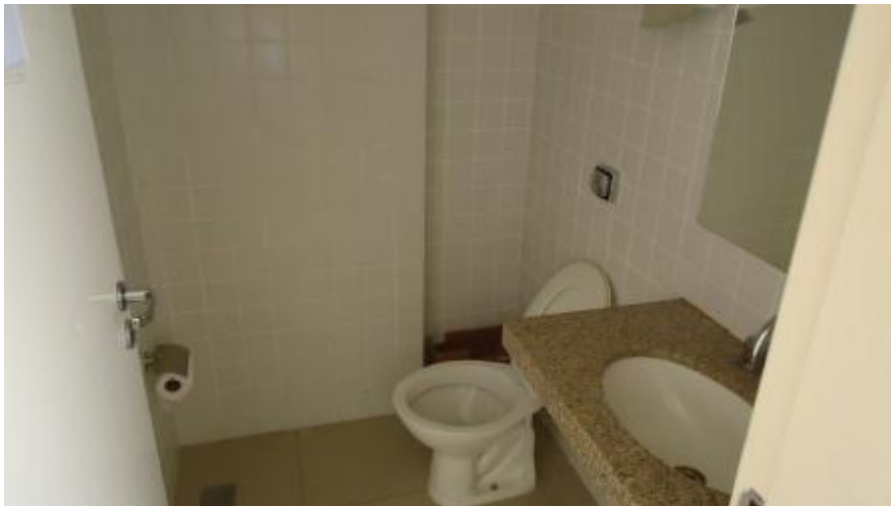
BANHEIRO MASCULINO (ER 6º ANDAR)
